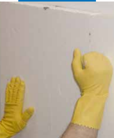
Pressatura dei pannelli dopo la posa per garantire la buona adesione al supporto
