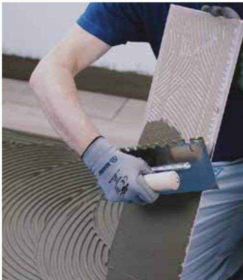
Posa della pavimentazione in ceramica o materiale lapideo con idoneo adesivo Mapei di classe non inferiore a C2
