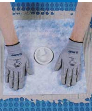
Impermeabilizzazione dello scarico con Drain Vertical/ Drain Lateral
