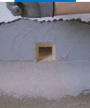
Impermeabilizzazione dello scarico con Drain Front
